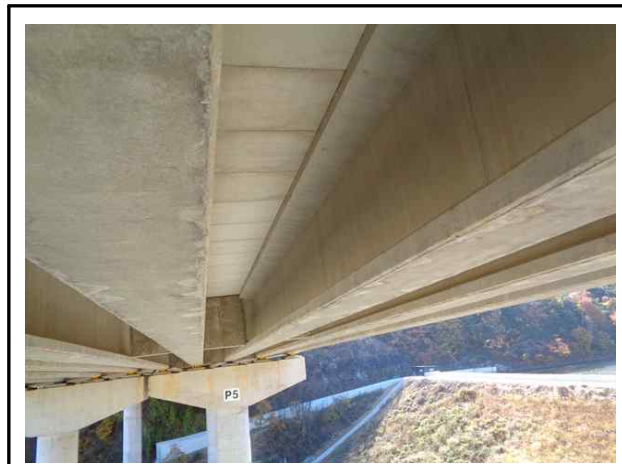
거더 내측 전경
