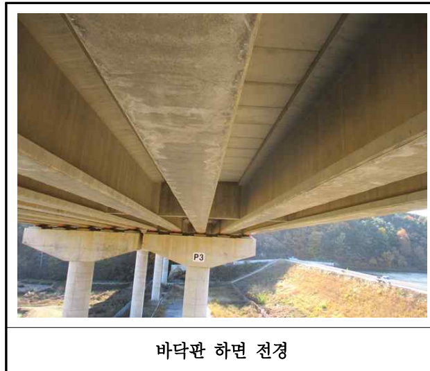
【사진 20.3.25】 바닥판하면 전경
