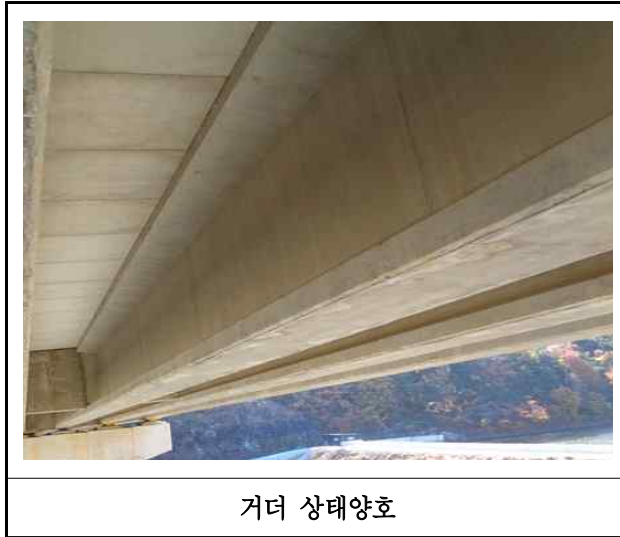
【사진 20.3.28】 거더 손상현황
