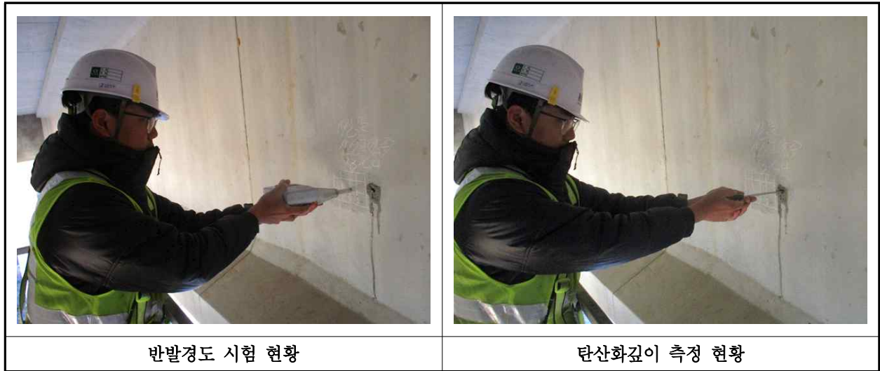
【사진 20.4.1】 콘크리트 내구성조사 현황
