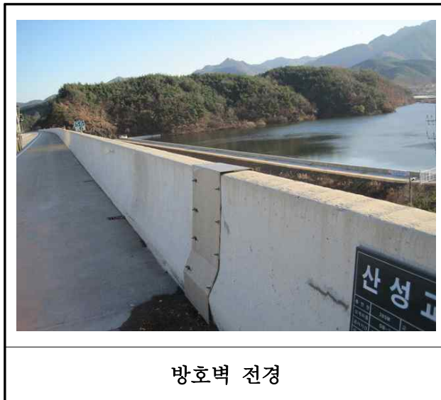
【사진 20.3.46】 방호벽 및 중앙분리대 전경
