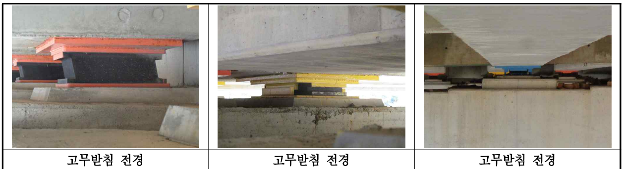
【사진 20.3.12】 교량받침 전경
