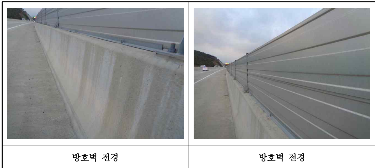
【사진 20.3.23】 방호벽 및 중앙분리대 전경
