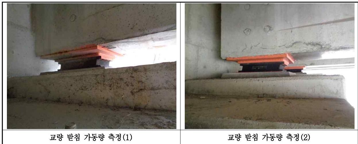
【사진 20.3.15】 교량받침 이동량 측정
