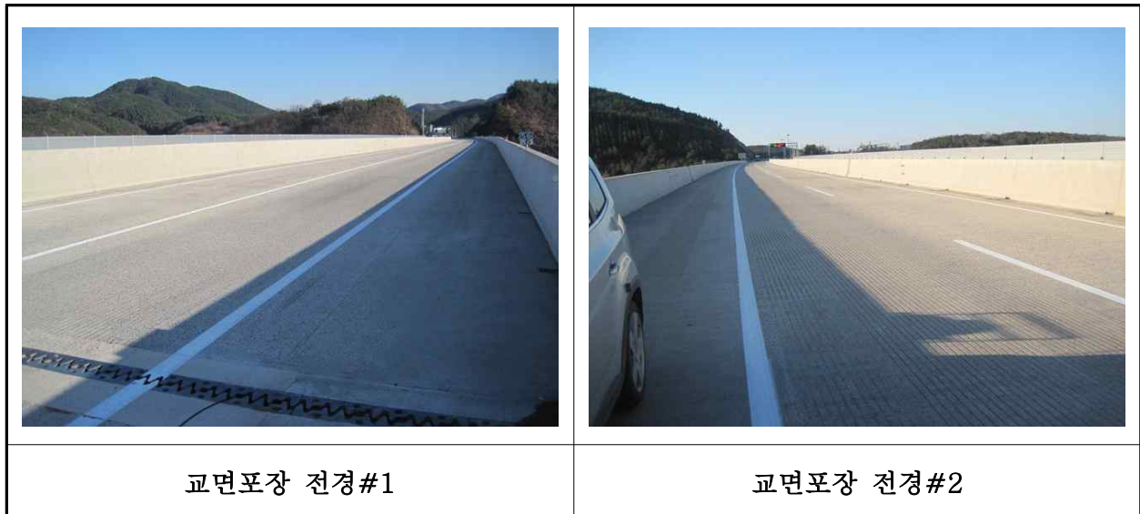
【사진 20.3.42】 교면포장 전경
