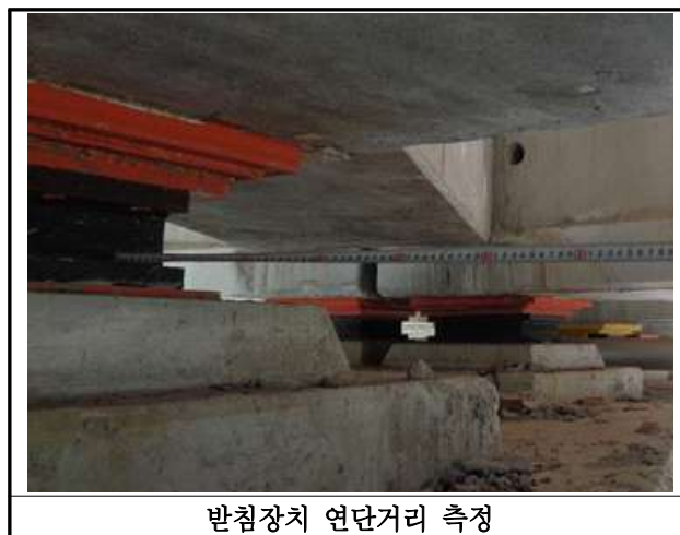
【사진 20.3.14】 교량받침장치 연단거리측정
