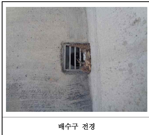
【사진 20.3.21】 배수시설 전경
