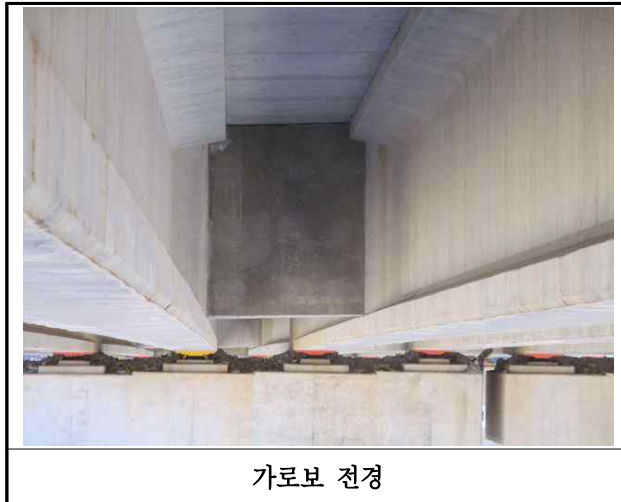
【사진 20.3.6】 가로보 전경
