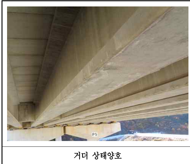
【사진 20.3.5】 거더 손상현황
