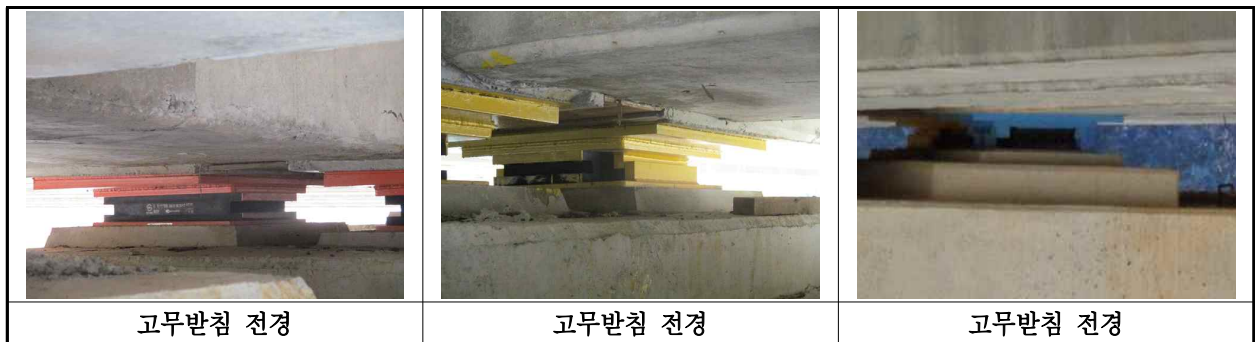
【사진 20.3.35】 교량받침 전경
