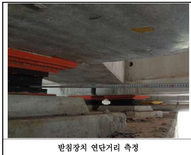
【사진 20.3.37】 교량받침장치 연단거리측정
